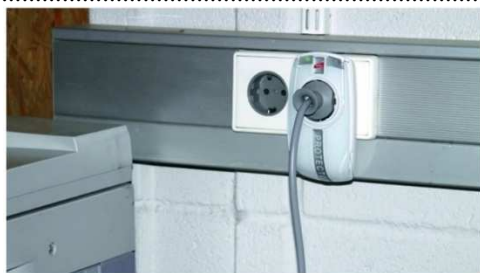
1. ábra: DPRO 230 sorozatjelű túlfeszültség-védelmi eszköz csatlakoztatása a konnektorba (dugaljba).
